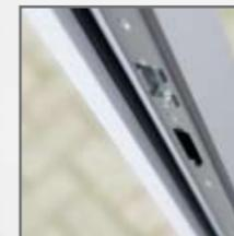
Anstelle einzelner Schließelemente schützt eine durchgehende Metallschließleiste deutlich besser vor einem Einbruch.
