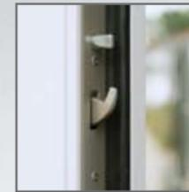
Unser 5-fach-Schwenriegel-Bolzenschloss macht ein Aushebeln der Tür fast unmöglich.
